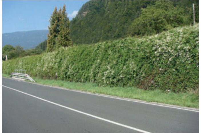
Die begrünte Lärmschutzwand fügt sich harmonisch in die Landschaft ein.
